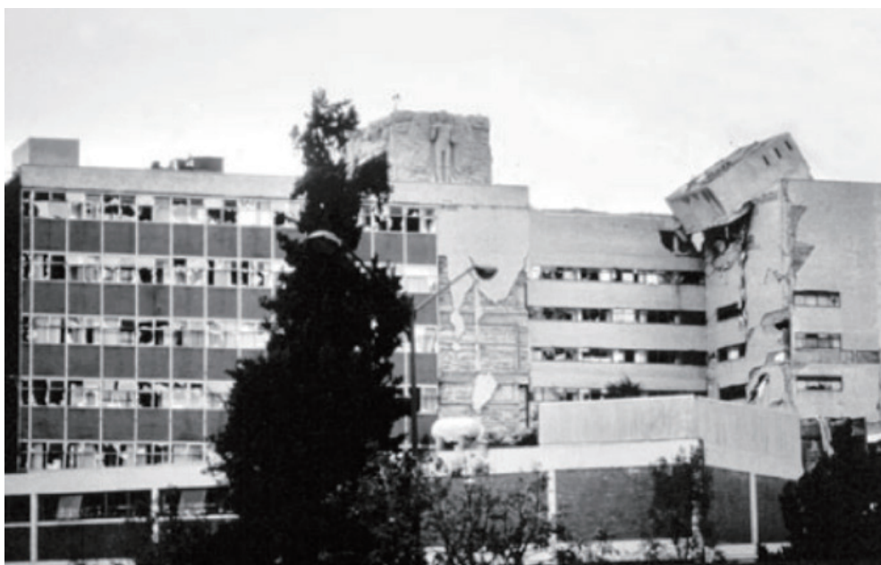
Figura 1. Daños estructurales en un hospital causados por estanques de agua en el techo (Organización Panamericana de la Salud, 2004).
