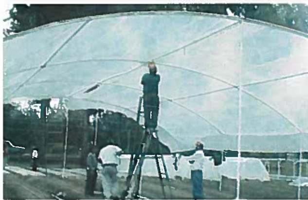
Construcción de Macro-túneles
