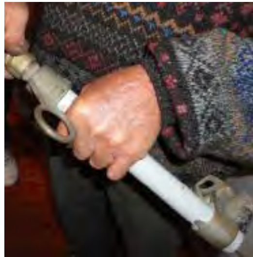
Figura 16. Asegurar el fusible
